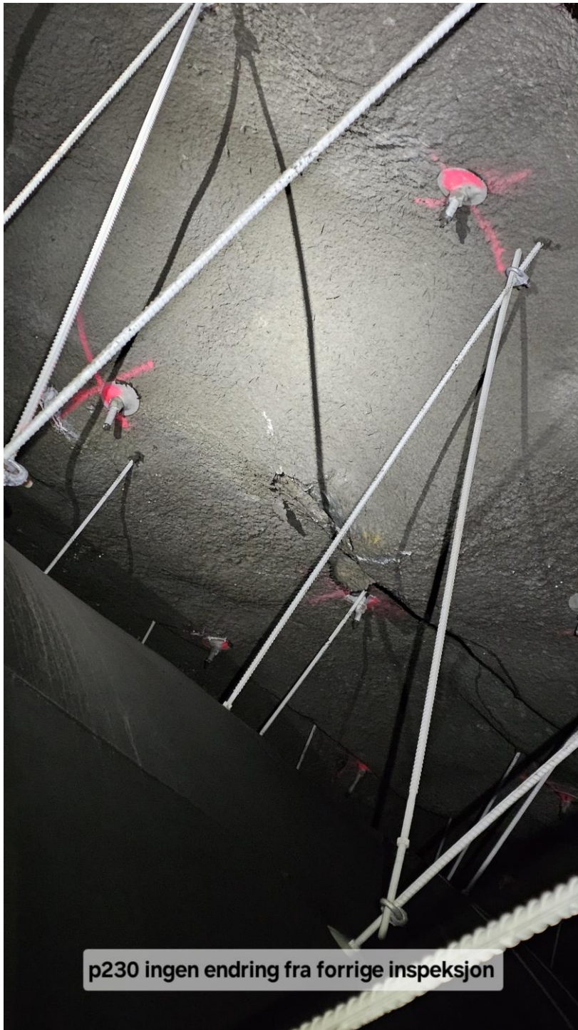
Foto 5. Pel 230 høyre side. Sjekkpunkt fra forrige inspeksjon. Ingen endring.
