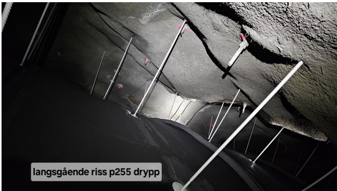
Foto 7. Pel 255 høyre side. Langsgående riss med drypp.
