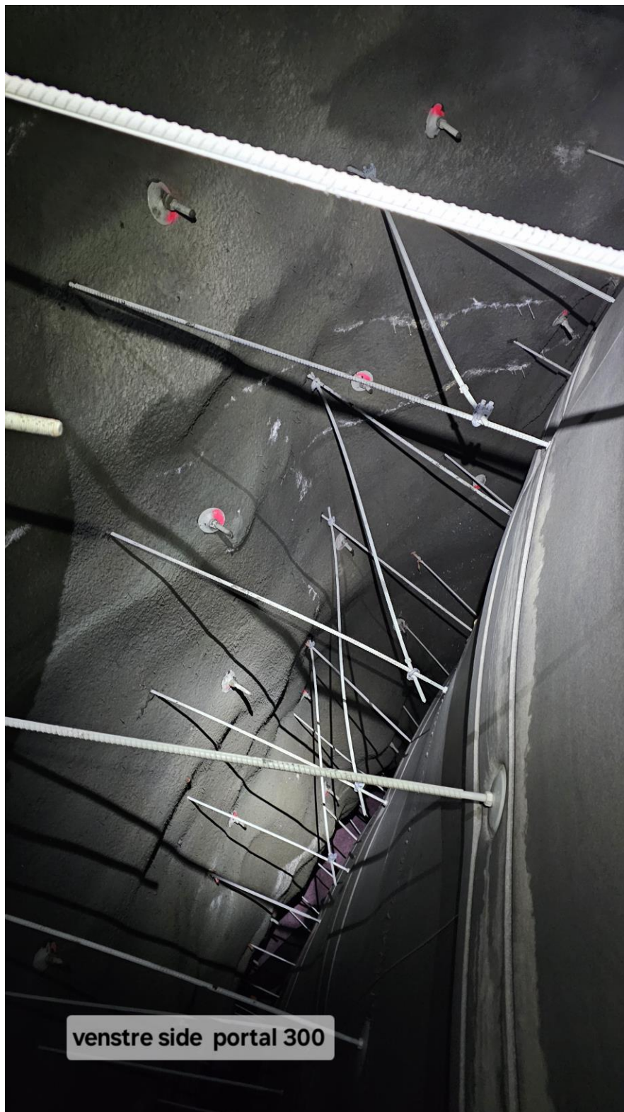
Foto 6. Pel 300 ved portal. Mindre kalkutfellinger, riss og drypp. Ellers god tilstand.
